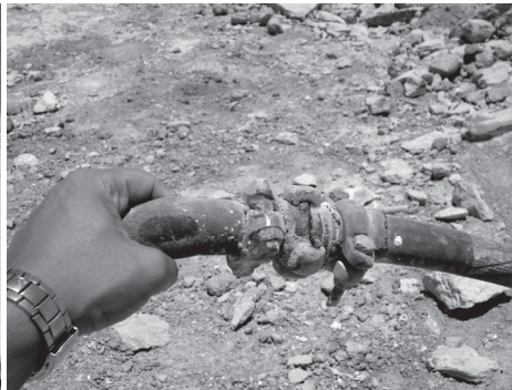
Conexão de mangueiras sem dispositivo auxiliar Hose connection with no protection
