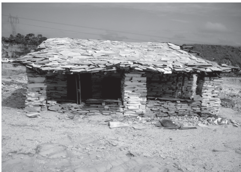
Construção para alojamento de funcionários Construction for workers lodging
